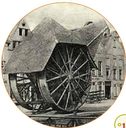
**Kraanbrug** significa literalmente 'el puente de la grúa'. Un poquito pasado la casa **Los Diablillos**, al otro lado del puente, hubo por 600 años una **grúa** enorme para descargar y cargar los barcos que atracaban aquí. Para hacer funcionar la grúa, varios obreros tenían que correr dentro de las **gigantescas ruedas** de la grúa. A estos obreros les llamaban los **kraankinderen**.
