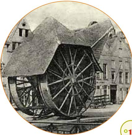
**Kranbrücke ?!** Genau! Etwas weiter entfernt als das Haus **Die Teufelchen** stand auf der anderen Seite der Brücke 600 Jahre lang ein riesiger **Kran**, der die Schiffe, die hier anlegten, be- und entlud. Damit der Kran funktionierte, mussten Menschen in den **riesigen Rädern** des Krans laufen! Diese Helfer nannte man auch die **Krankinder**.
